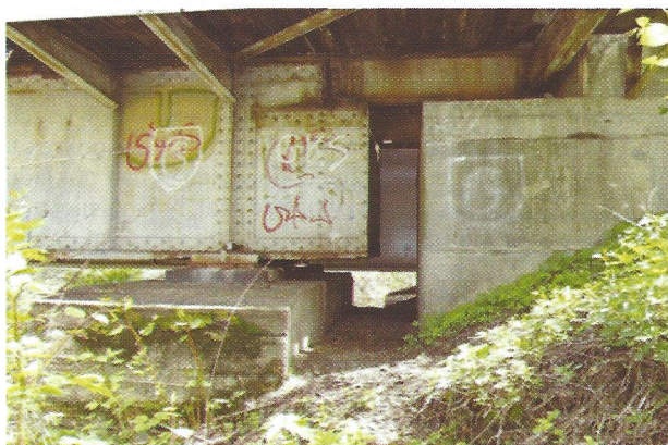
Rys. 2. Widok na przyczółek i przęsło skrajne [6] Fig. 2. View of the abutment and span [6]
